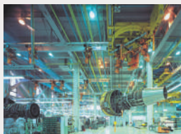
搬运喷气式飞机引擎起重机系统
